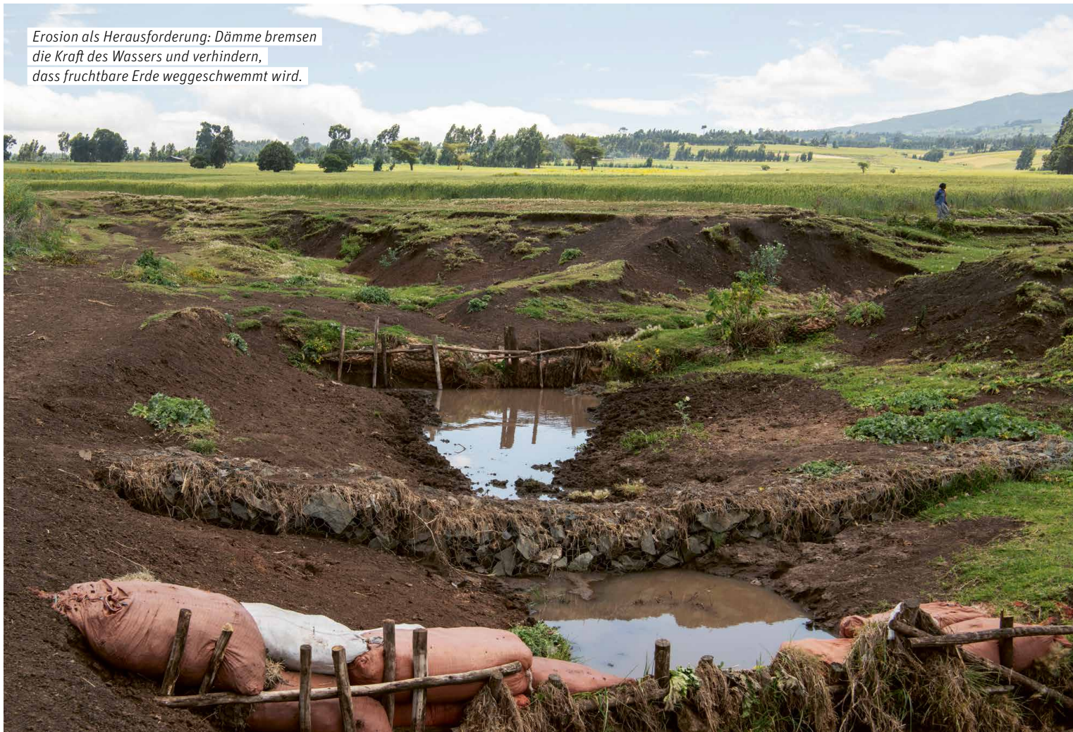
Cleverer Techniken beleben das Land: In horizontal verlaufenden Gräben sammelt sich Wasser und kann versickern.
